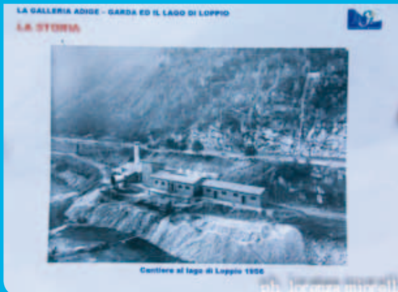
Lago di Loppio: cantiere della galleria Adige-Garda
